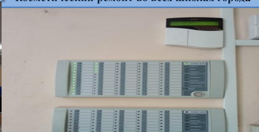
Установка и ремонт АПС в школах №2,5,7
